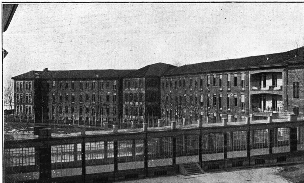
Braccio del secondo padiglione.
