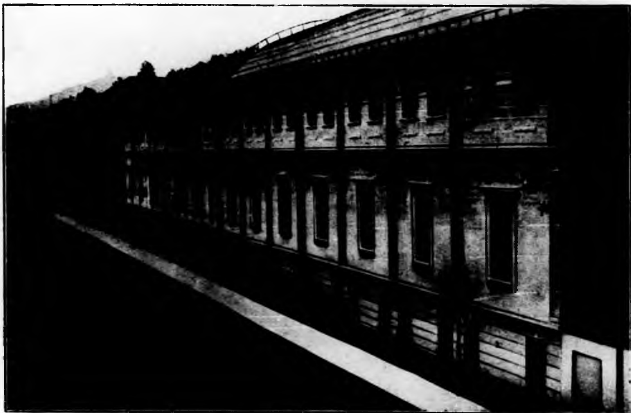
Teatro di posa di via Luisa del Carretto
