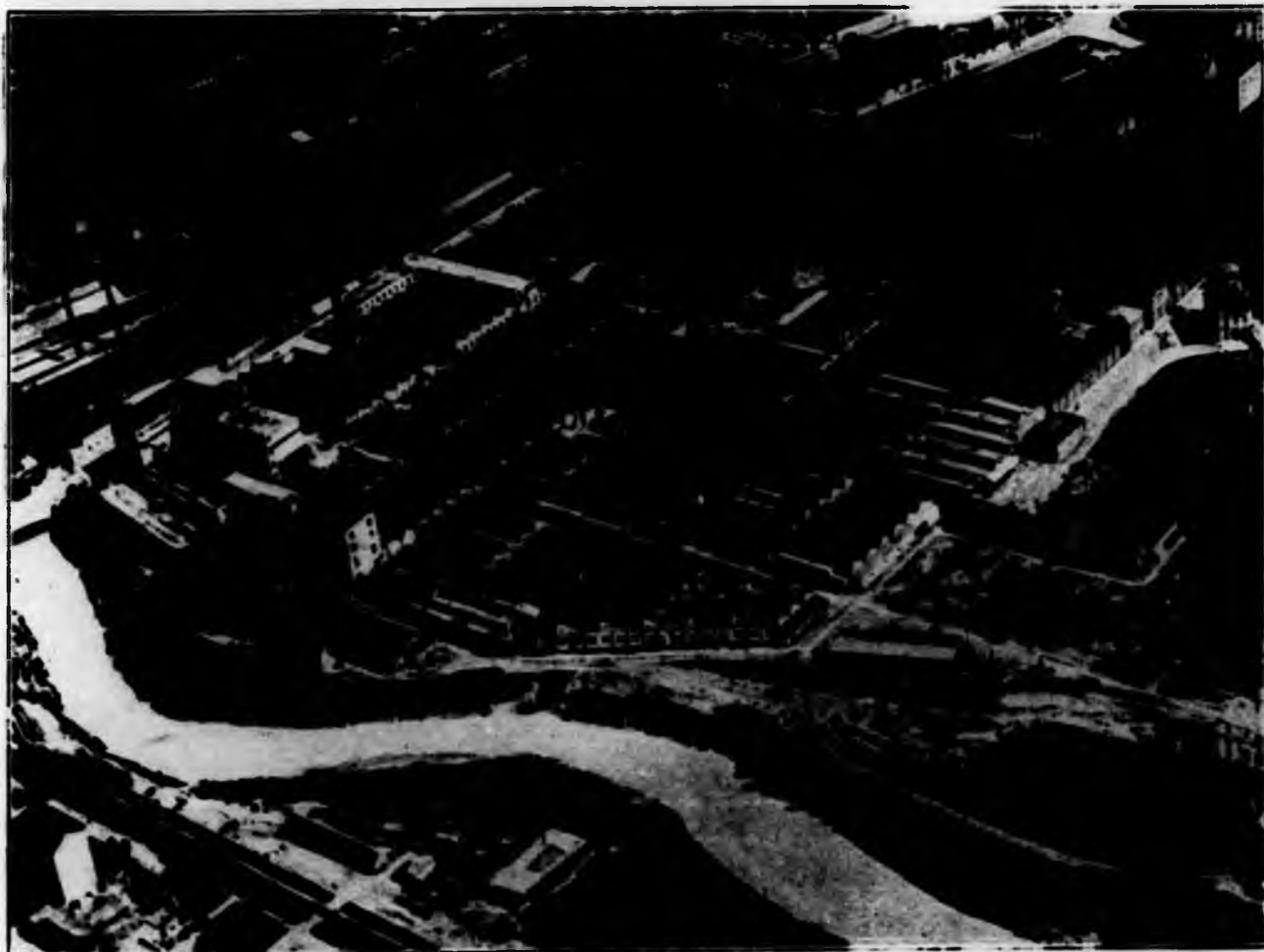
Veduta panoramica dello Stabilimento di Torino.
