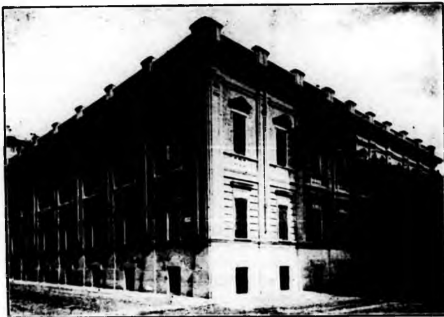
Azienda Elettrica Municipale - Via Bertola angolo Via S. Dalmazzo.
