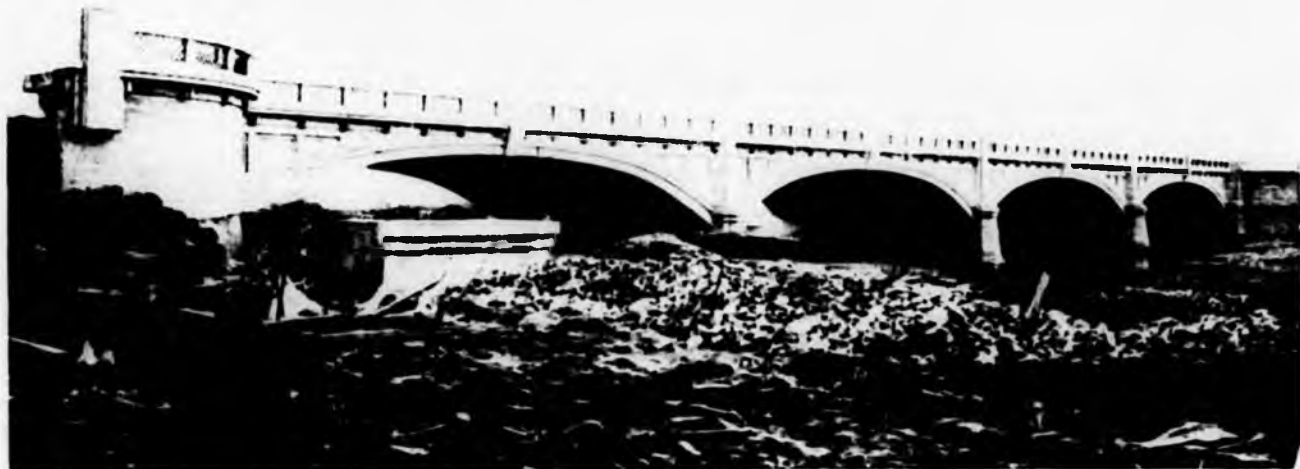
Ponte Ferdinando di Savoia sulla Stura in Torino.
