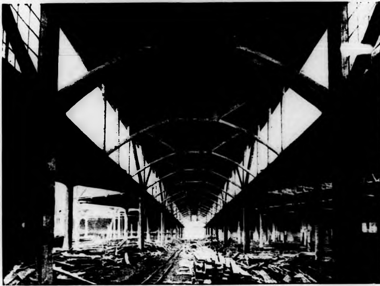
Corsia Centrale della Rimessa Tramviaria.
