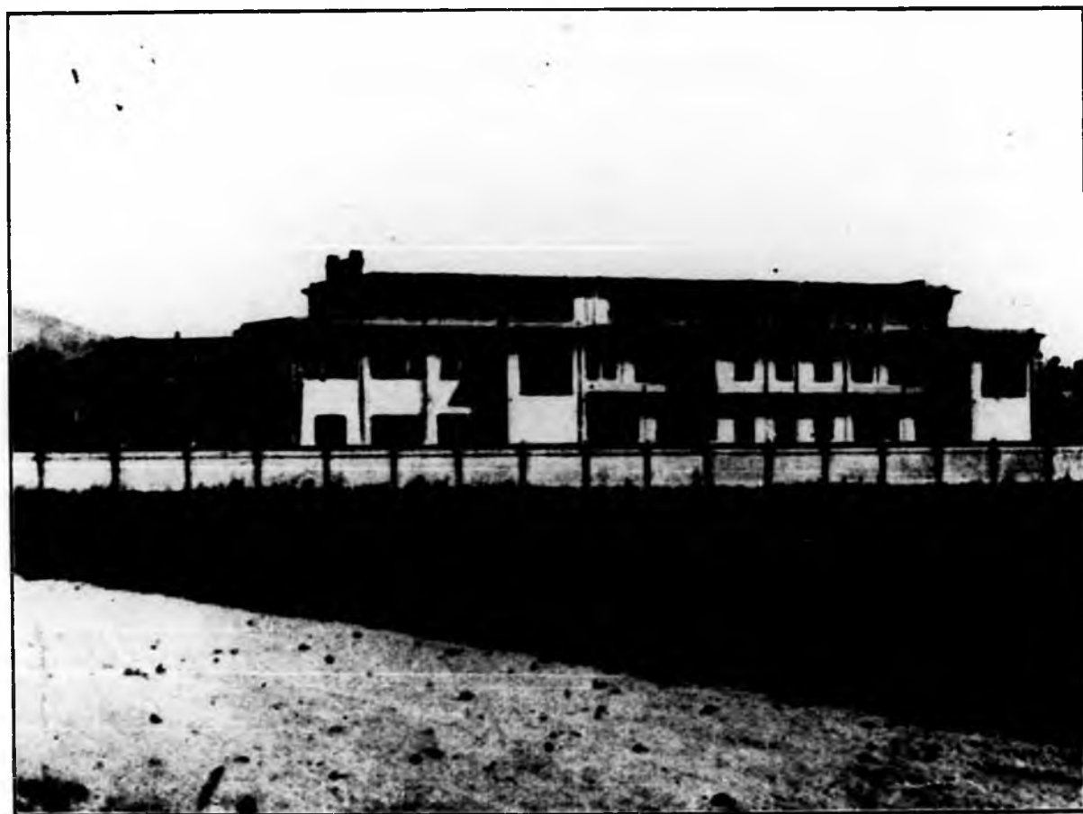
La nuova centrale dell'Azienda Elettrica Municipale in corso Sebastopoli.
