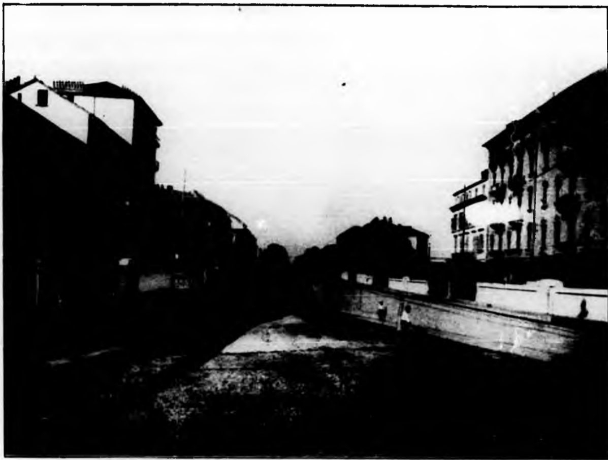
Il sottopassaggio di Corso Regina Margherita.
