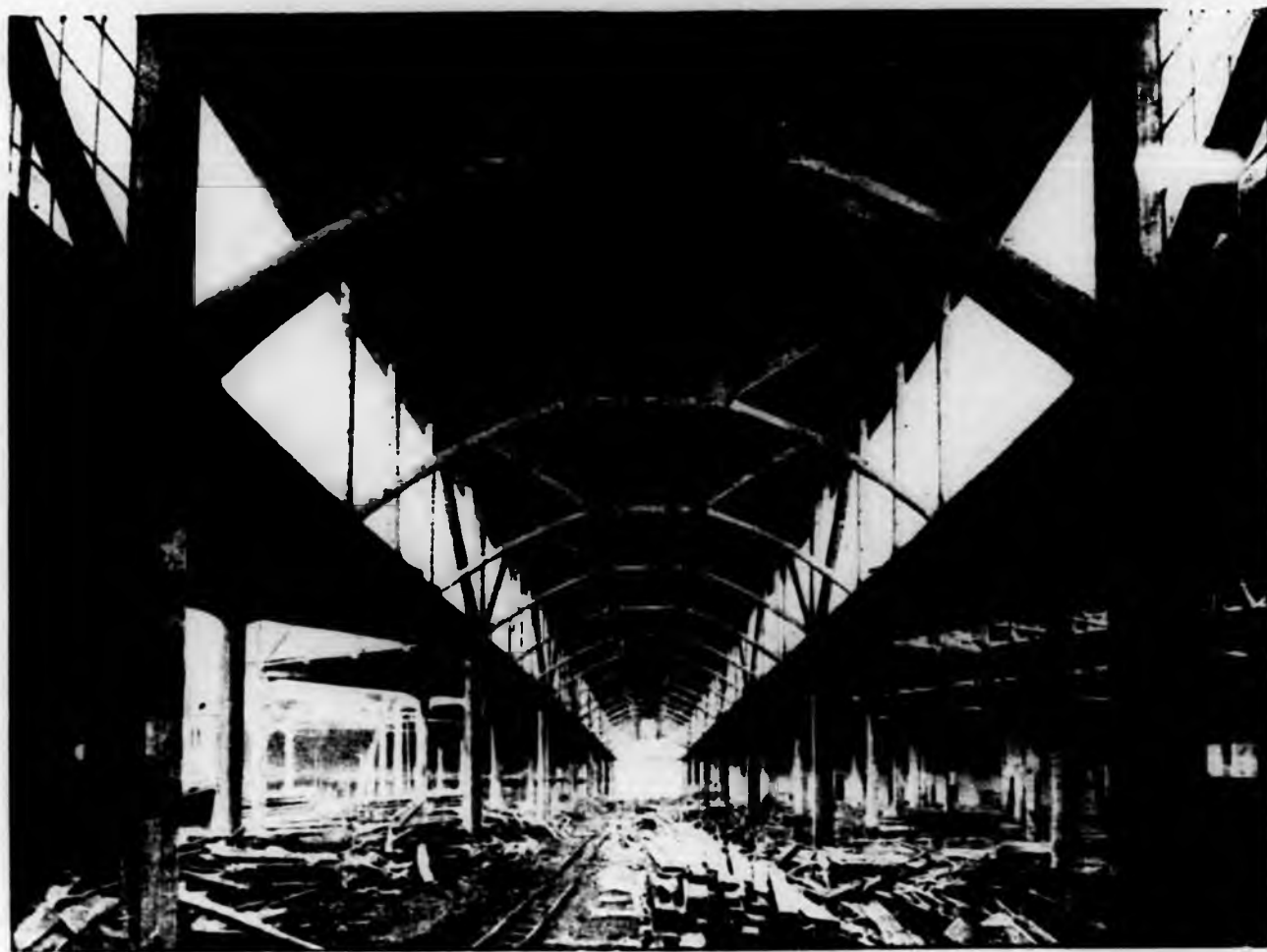
Corsia Centrale della Rimessa Tramviaria.
