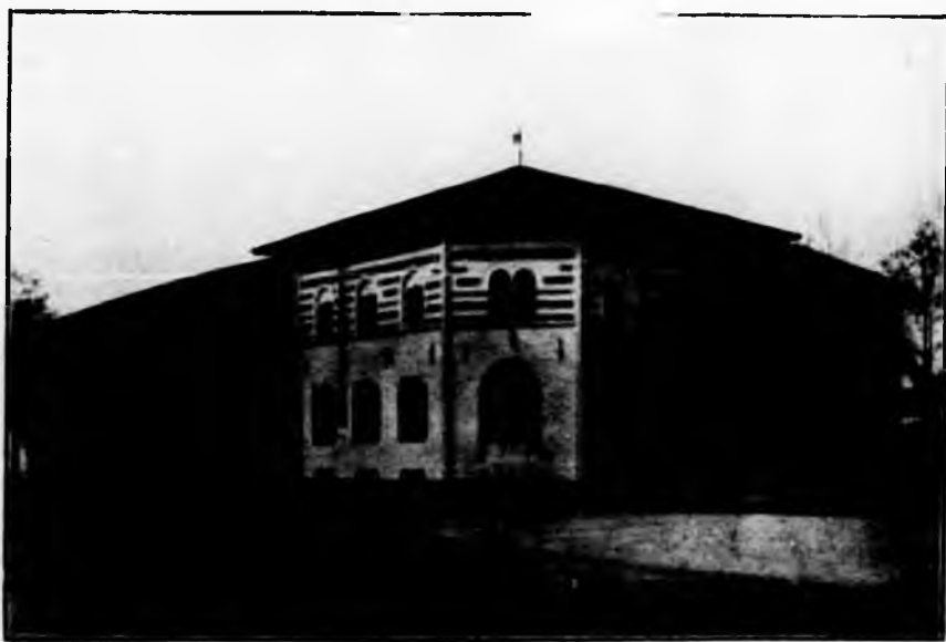
La nuova Sede Centrale.
