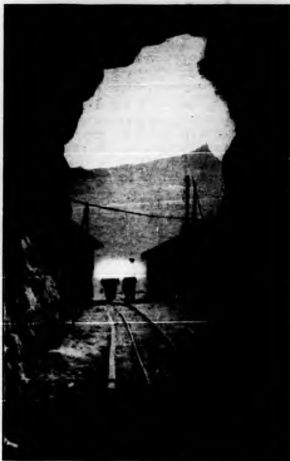
Finestra di attacco della galleria-serbatoio.
