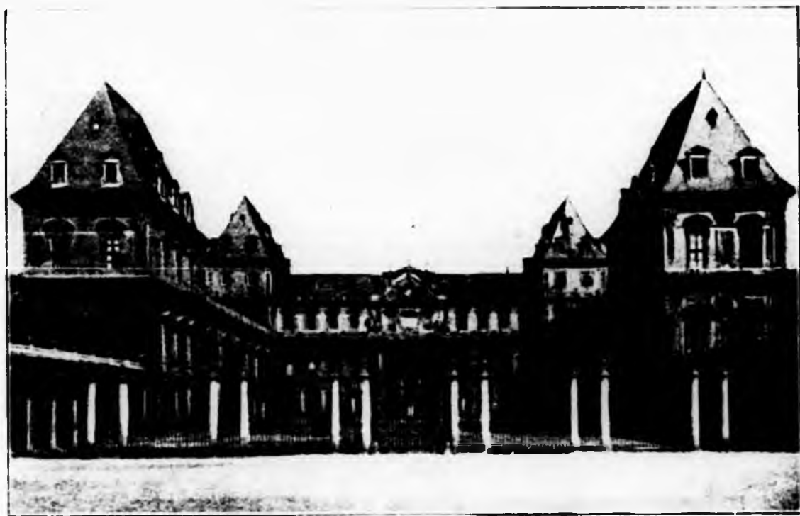
Castello del Valentino - R. Scuola d'Ingegneria. Riscaldata a termosifone con pompa.
