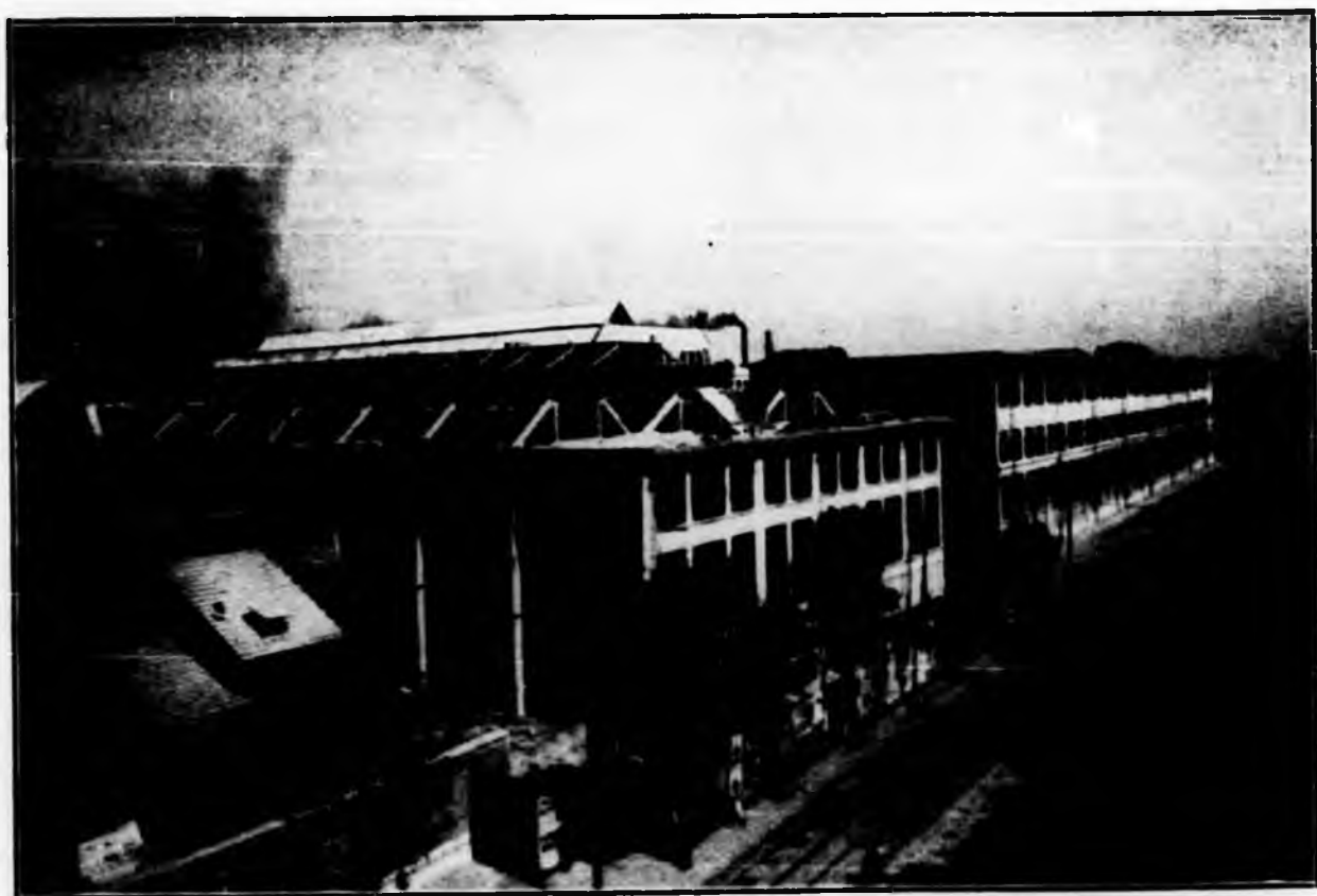
Società FIAT - Stabilimento Grandi Motori - Torino. Fabbricati dei nuovi Magazzini e delle nuove Fonderie con ossature di cemento armato, solai di grande portata, e coperture a capriate piane e paraboliche di grande luce.
