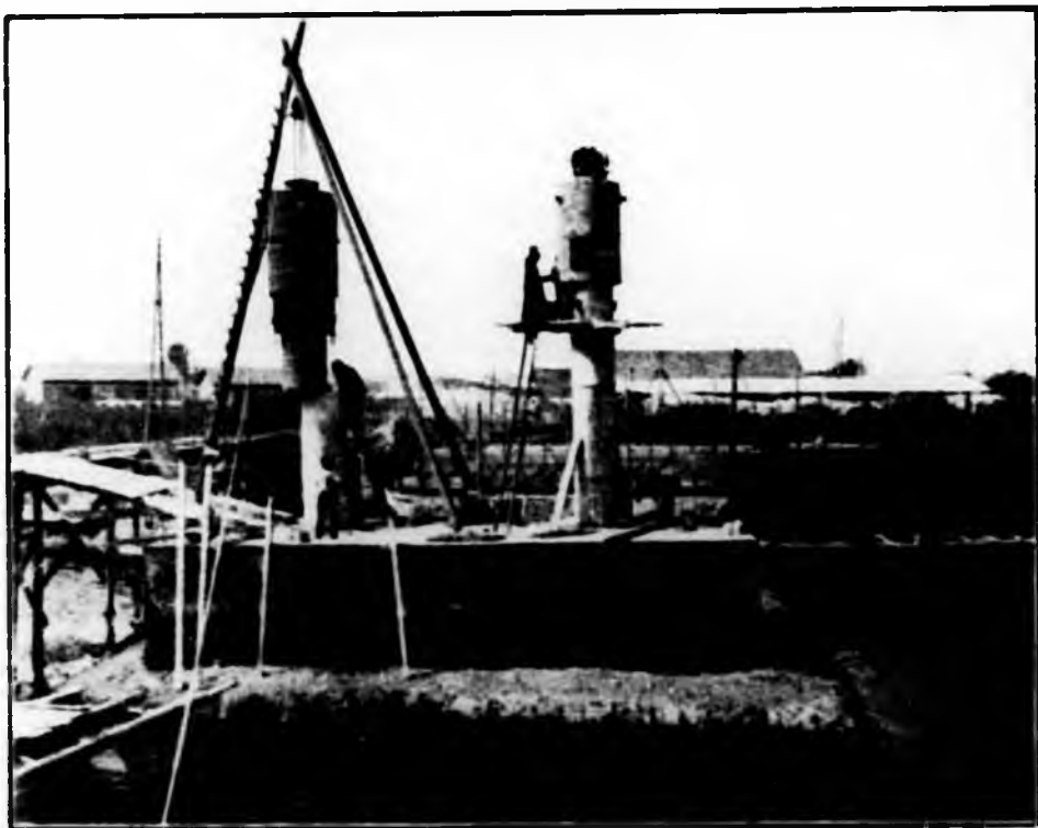
Ponte sul Po a Torino in Corso Belgio - Fondazioni ad aria compressa.
