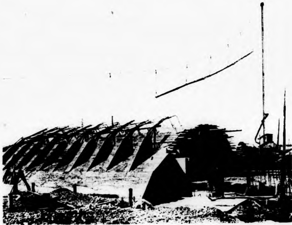
Spallone del Ponte sulla Stura in costruzione.
