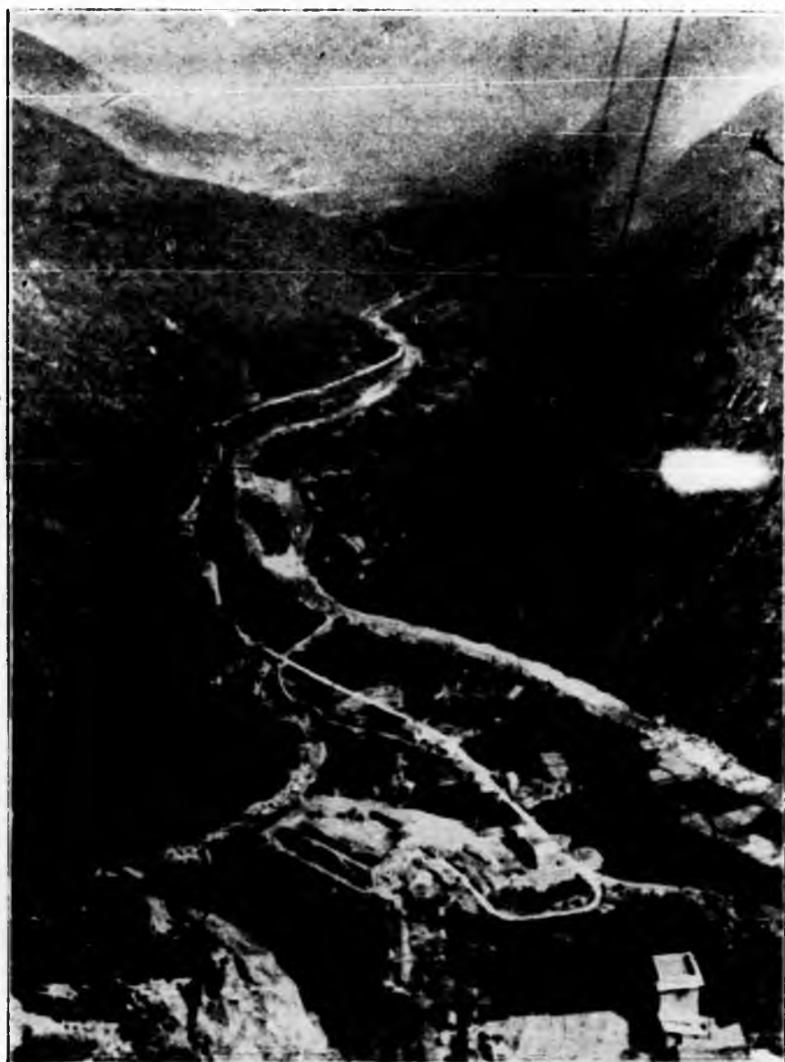
Impianto dell'Orco - Veduta generale del Cantiere di Rosone (Centrale)
