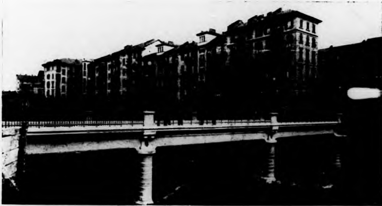
Ponte Rossini sulla Dora in Torino.
