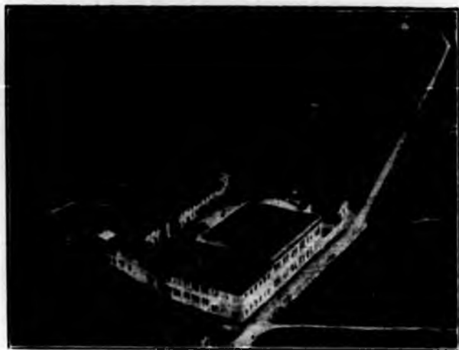
Stabilimento di Abbadia Alpina
