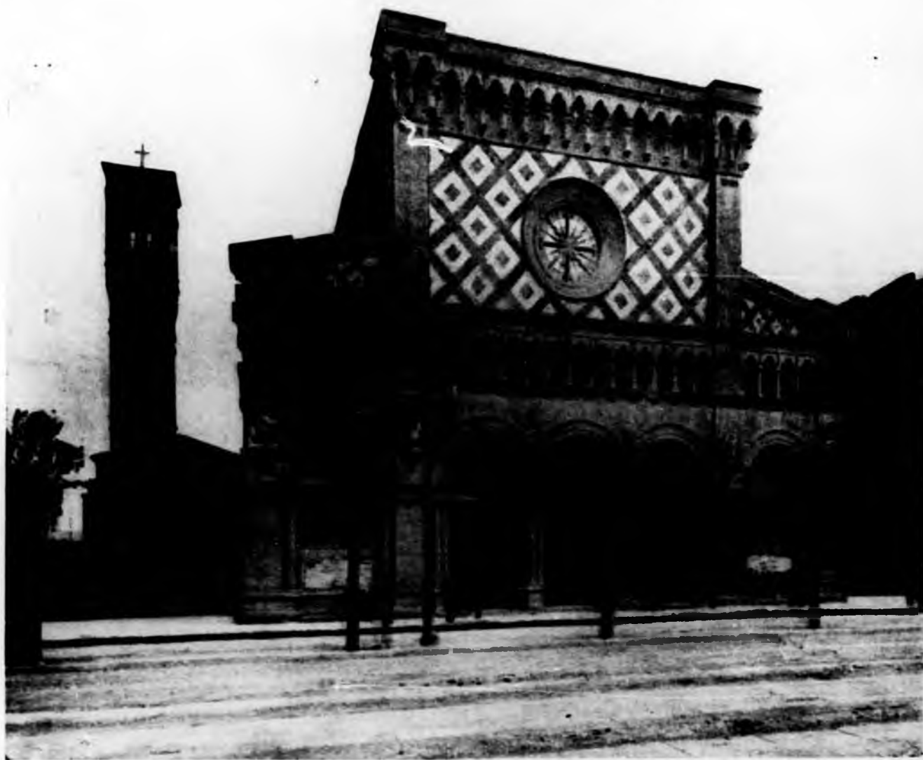
Chiesa di S. Gioachino in corso Ponte Mosca a Torino
