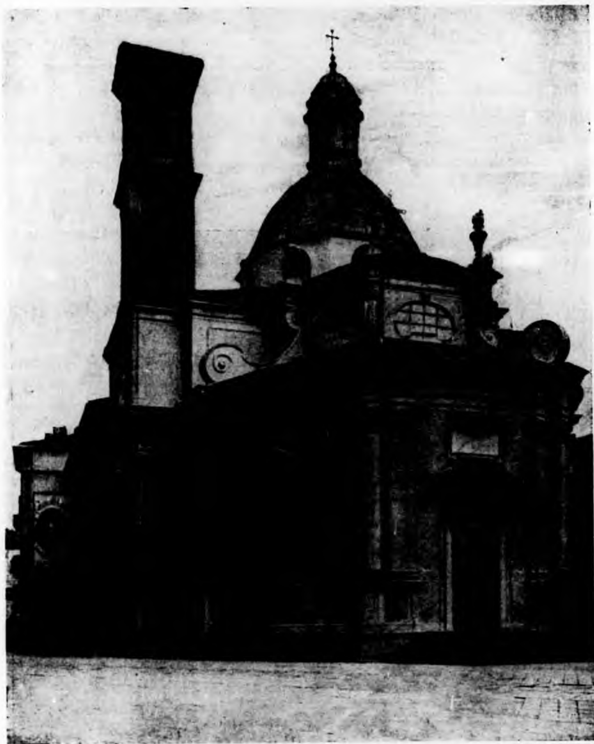
Chiesa di San Tomaso in via Pietro Micca a Torino. Sistemazione della fronte
