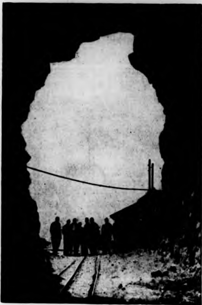
Finestra della galleria-serbatoio
