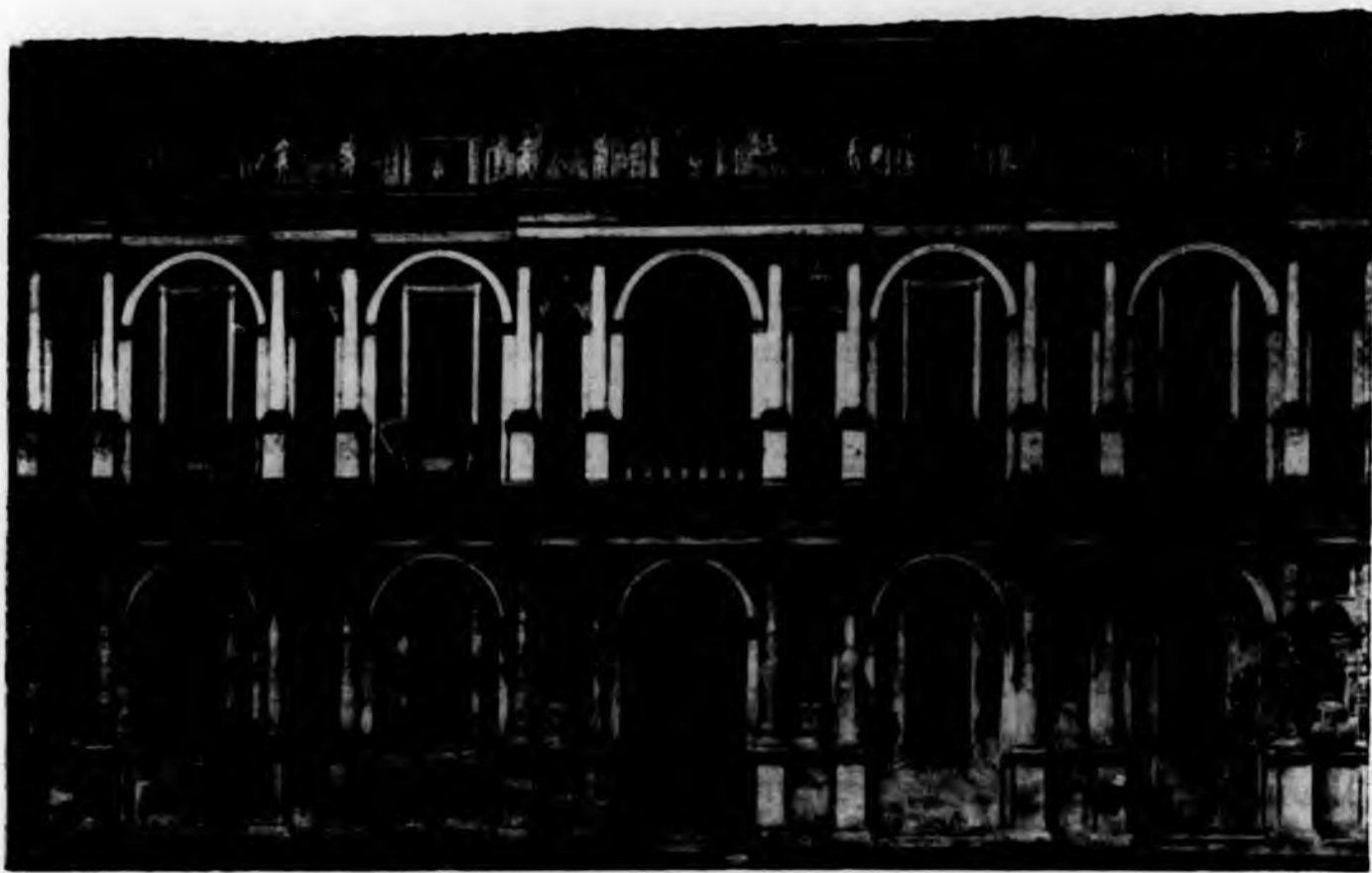
Casa Cravetta in Savigliano ove morì Carlo Emanuele I
