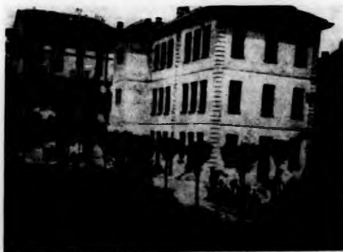
IL FABBRICATO DI NUOVA COSTRUZIONE
