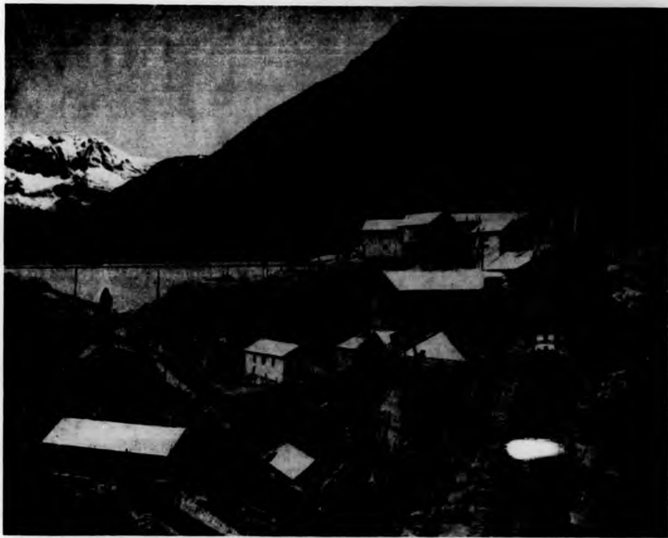
Cantiere di Cererole Reale - A sinistra la diga minore (Fot. Costamagna)
