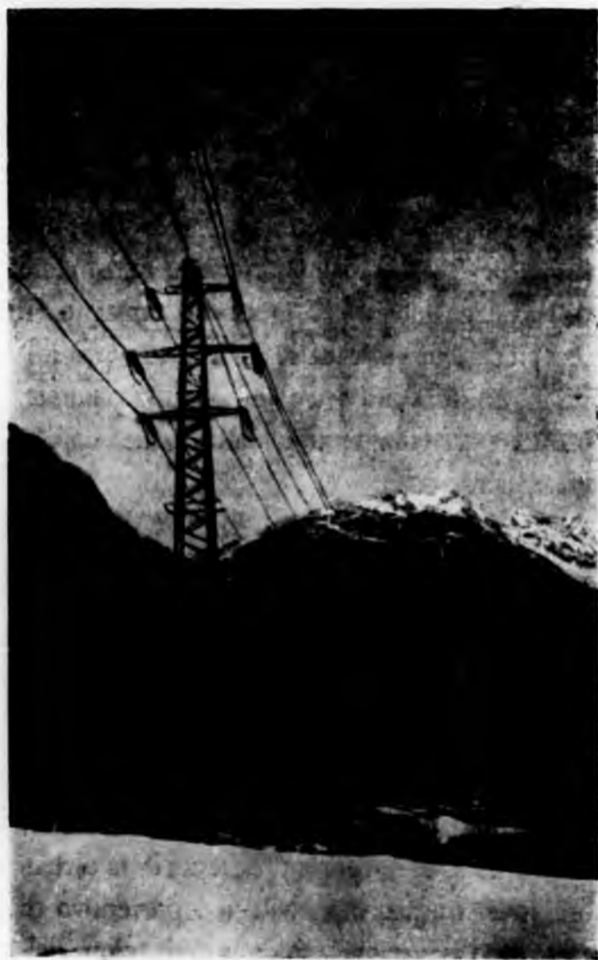
Linea elettrica Ronone-Torino a 90.000 V. Palo normale
