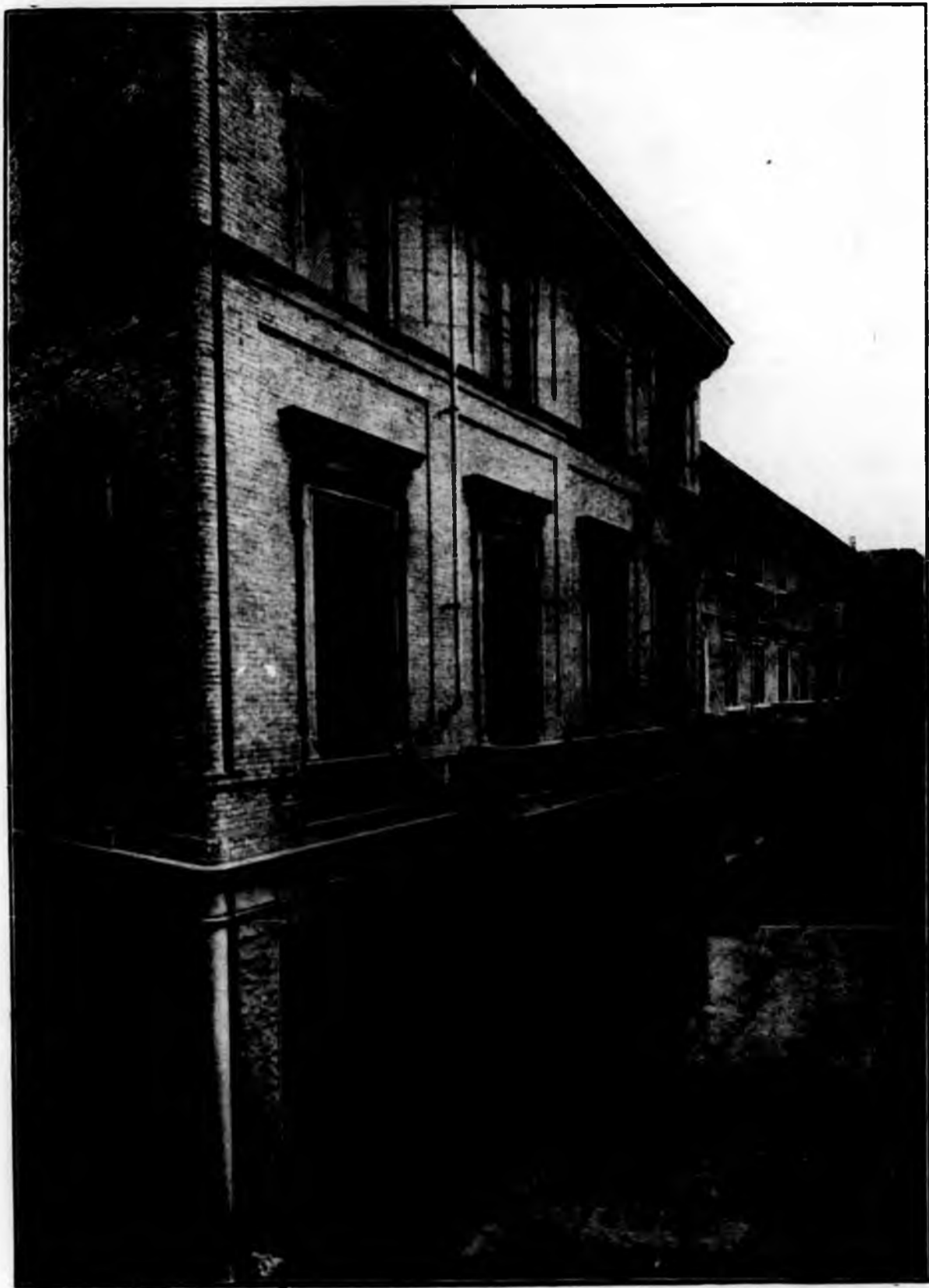
Istituto di San Paolo. Facciata dell'edificio
