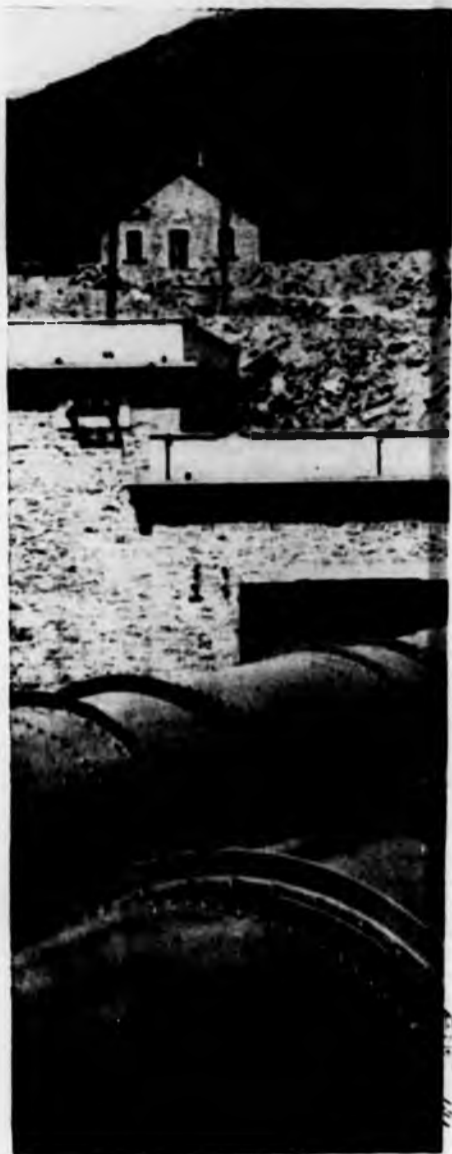
Vasche di carico - Inizio
