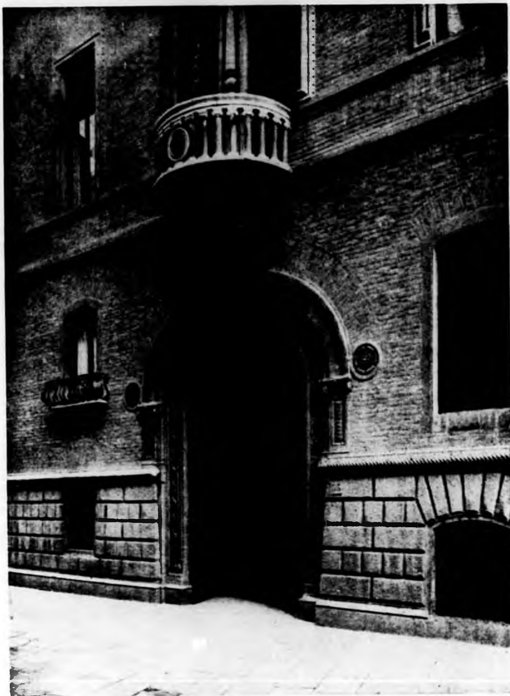
Particolare della fronte del palazzo Ceriana in via Arsenale, 3 a Torino
