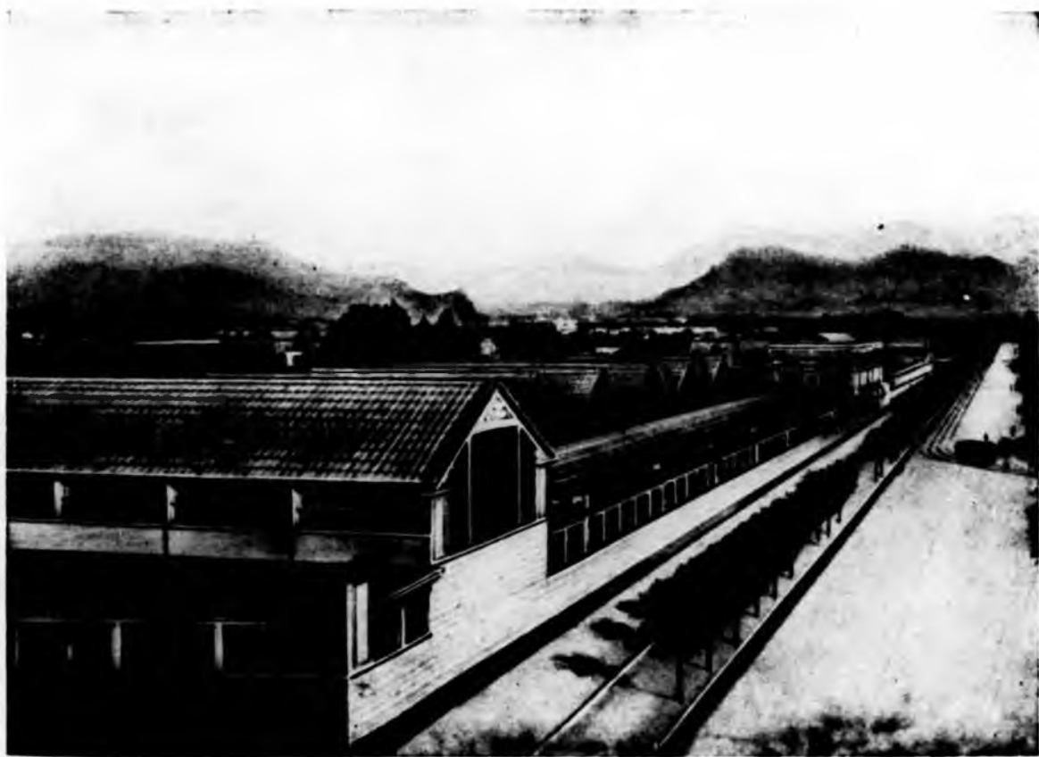
Officine di Corso Peschiera - Palazzina Uffici
