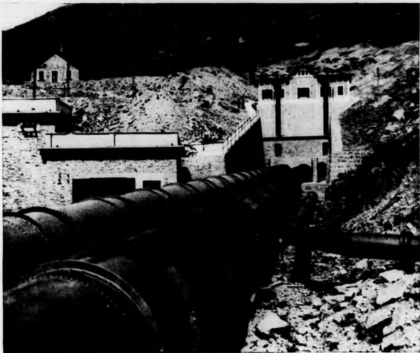
Vasche di carico - Inizio condotte forzate. (Fot. A. Pedrini - Torino)
