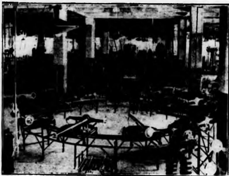
Un reparto del Lingotto: il montaggio del ponte
