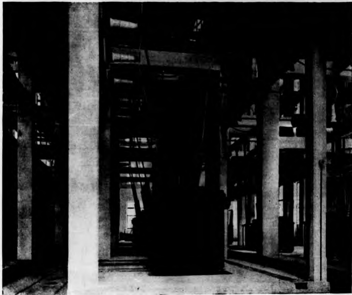
Interno fabbricato apparecchiature della Centrale di Rosone (F. A. Pedrini - Torino)
