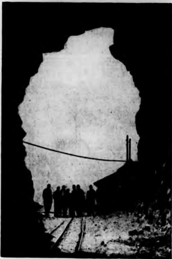
Finestra della galleria-serbatoio
