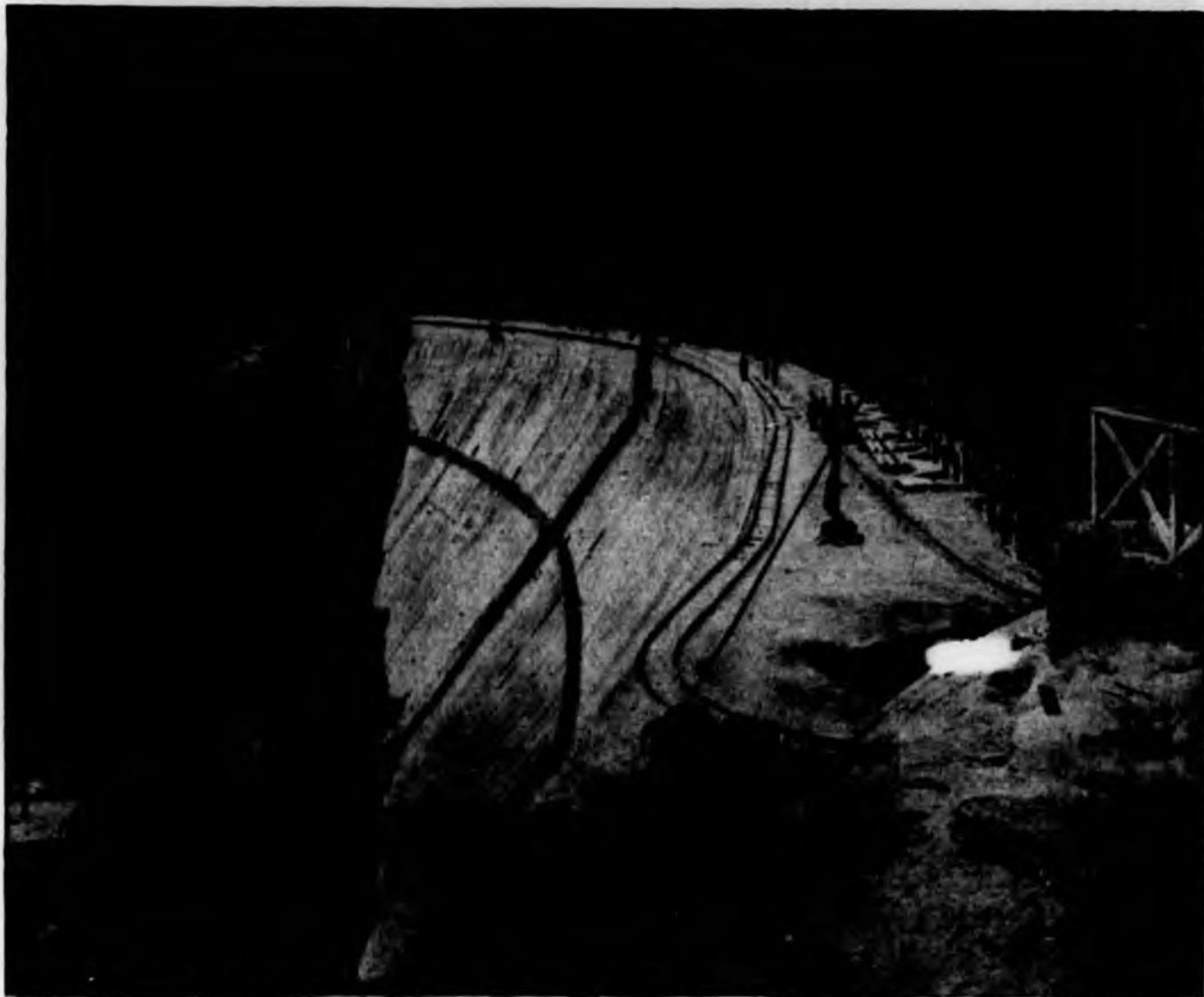
Diga a Ceresole Reale - vista dalla sponda sinistra. (Fot. A. Pedrini - Torino)
