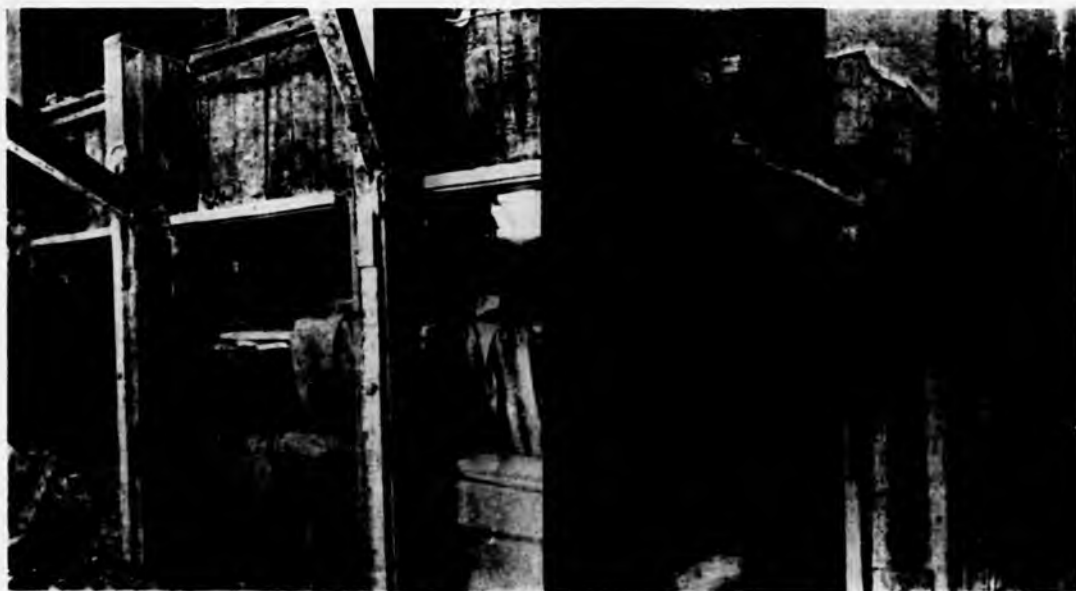
Lo stato delle travature all'inizio dei lavori di ricostruzione
