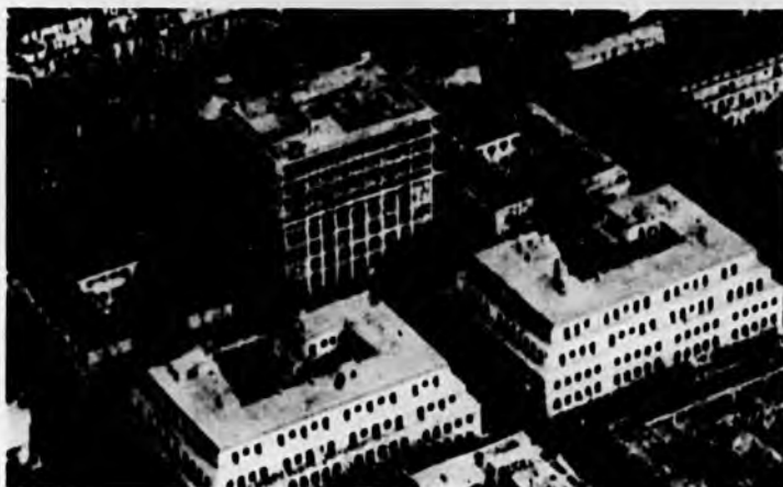
Gli edifici ricostruiti dalla S. A. Edilizia Piemontese nell'isolato Sant'Antonio da Padova Veduta aerea - Nel centro, il nuovo grande albergo a torre di 12 piani
