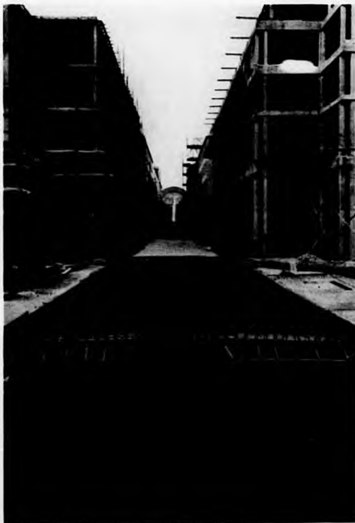
Via Roma - Il solettono di copertura della galleria sotterranea - Particolare dell'armeria Le costure in cemento armato degli edifici
