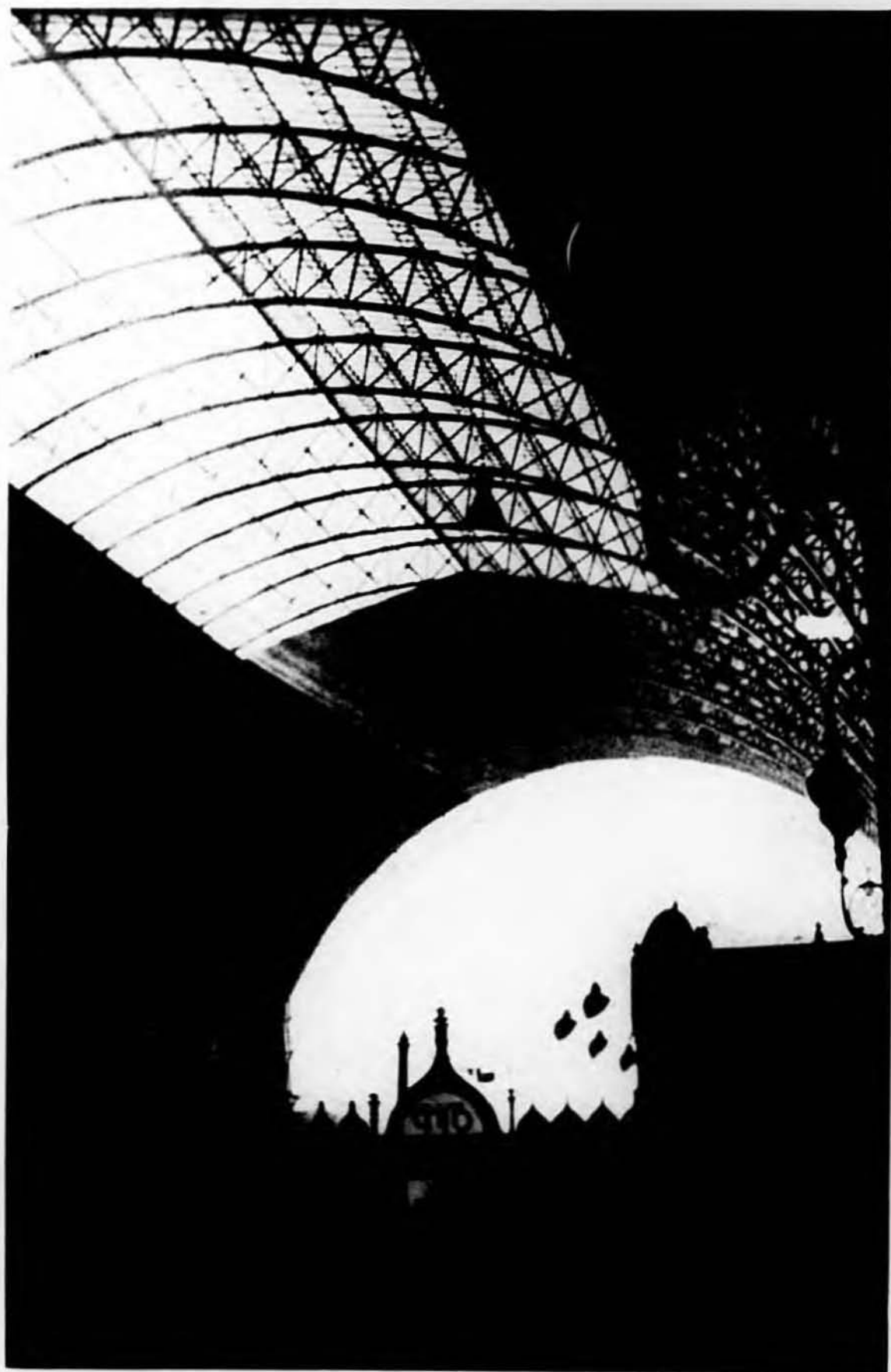
L'ampia tettoia che protegge atrio e binari
