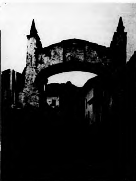
La porta sud dall'antica strada di Pinerolo
