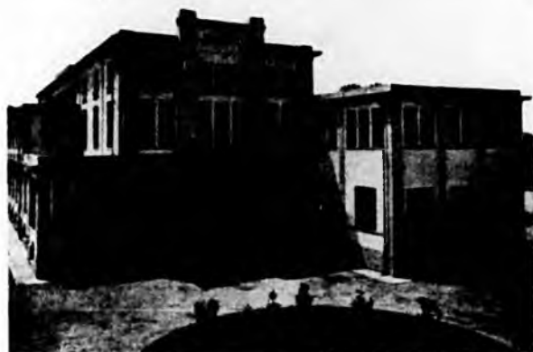
Centrale di Corso Sebastopoli
