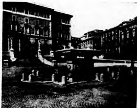
Roma - Piazza del Venezia - Pavimentazione in cubetti di porfido tipo C
