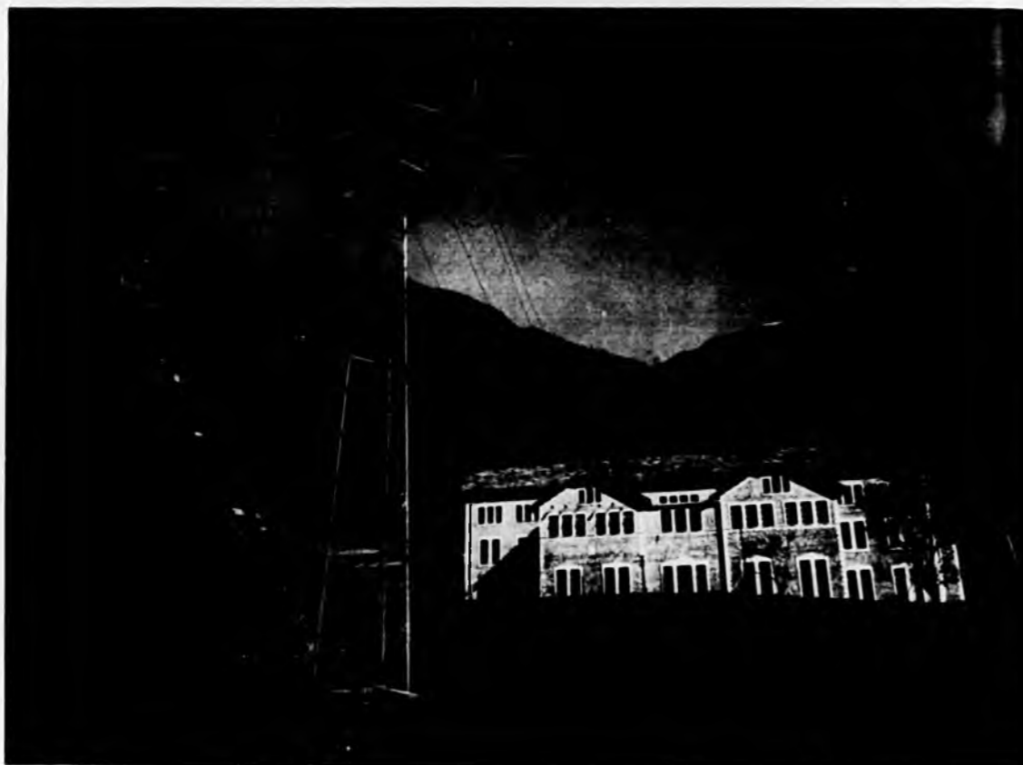
Centrale di Rosone e Valle del Piantonetto
