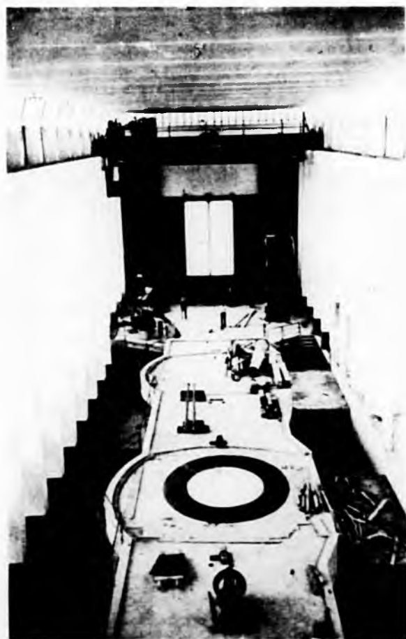
Fig. 2. Lavori di rifacimento (interno) della Centrale di Vizzola Ticino
