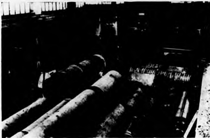
Condotte forzate pronte per la posa in opera
