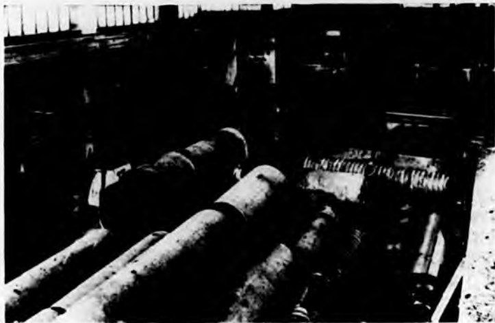
Condotte forzate pronte per la posa in opera
