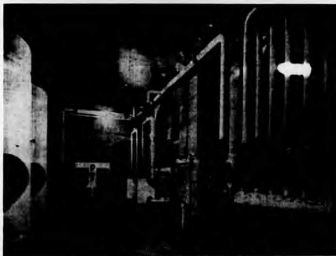
Centrale elettrotermica del R. Liceo-Ginnasio N. D'Azeglio
