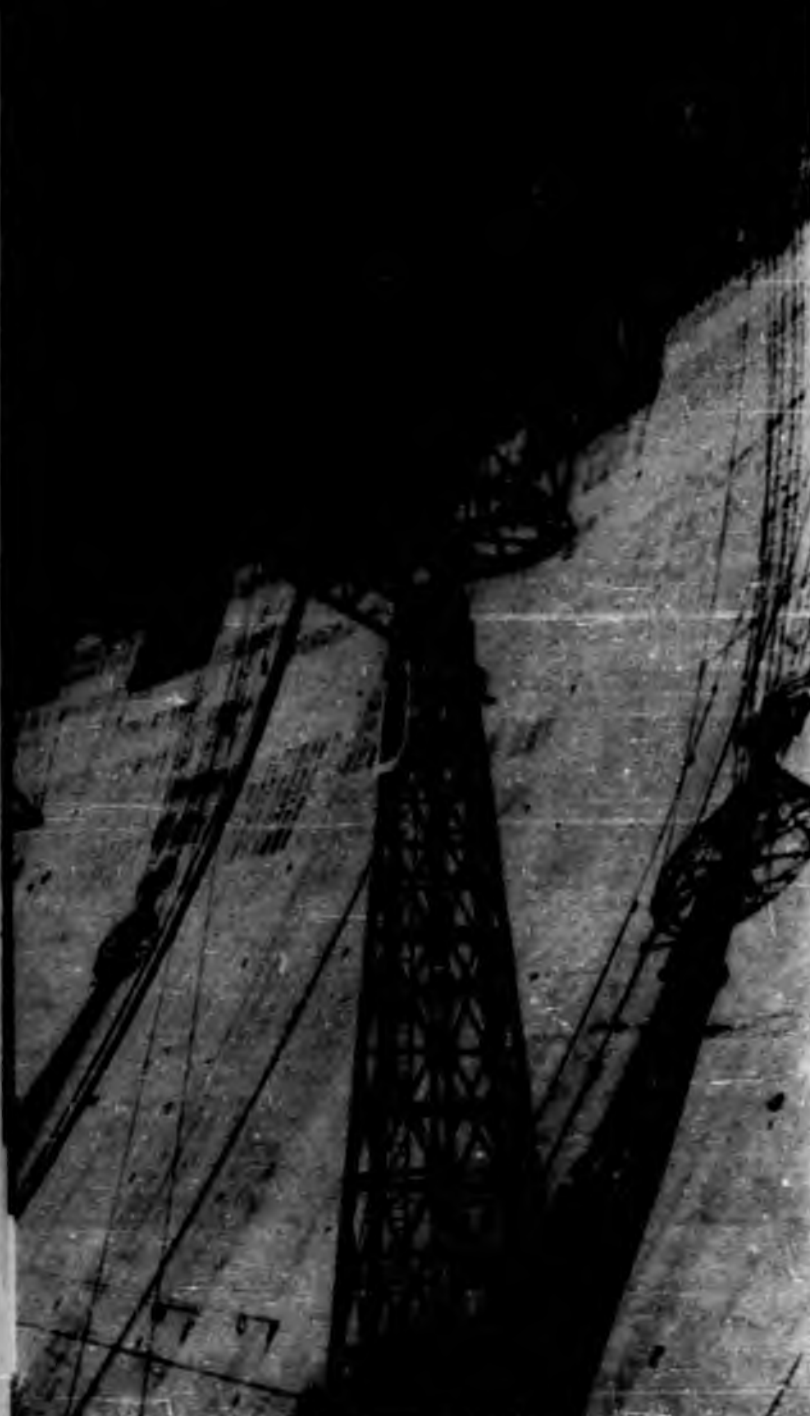
Fig. 8. - La diga di Pian Telesio vista da valle con i grandi derrick per la distribuzione del calcestruzzo.
