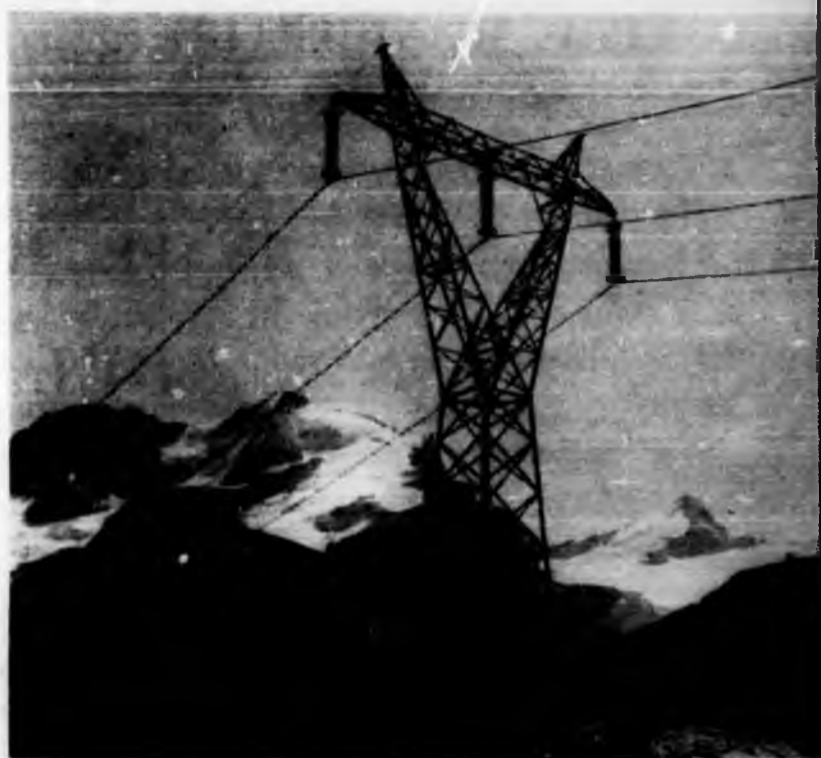
Fig. 14. - L'elettrodotto a 220 kV Valle Aosta-Valle Orco al colle del Nivolet. Nello sfondo il Gran Paradiso.
