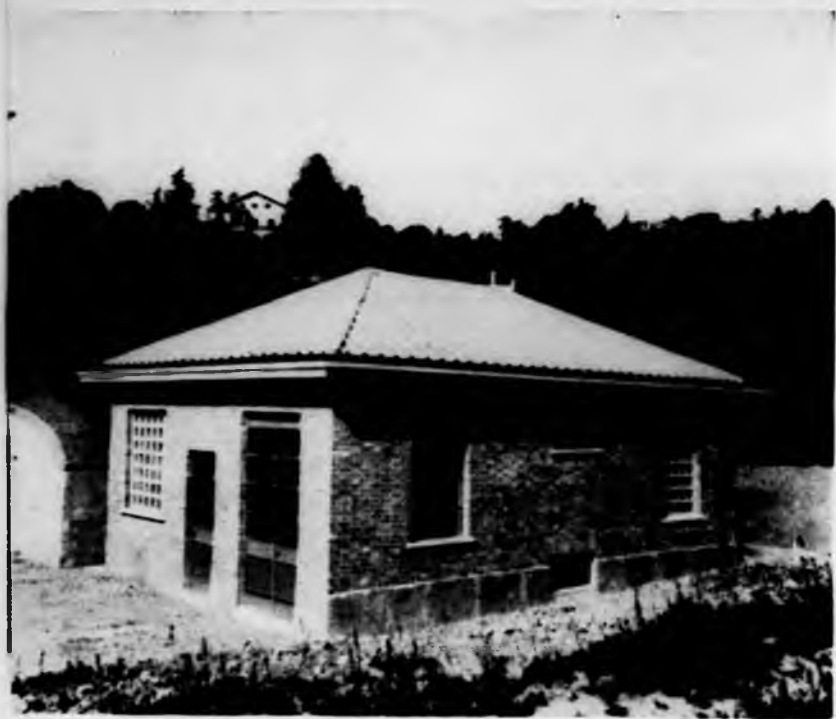
Impianto dell'Eremo - Centrale di sollevamento in Valsalice.
