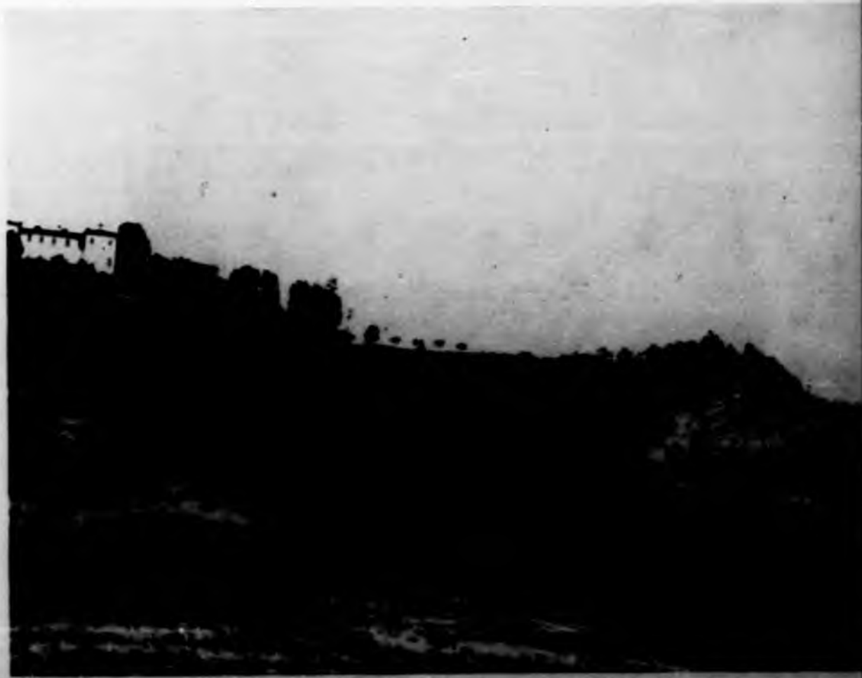
Il castello di Montalero e la valle Cerrina.
